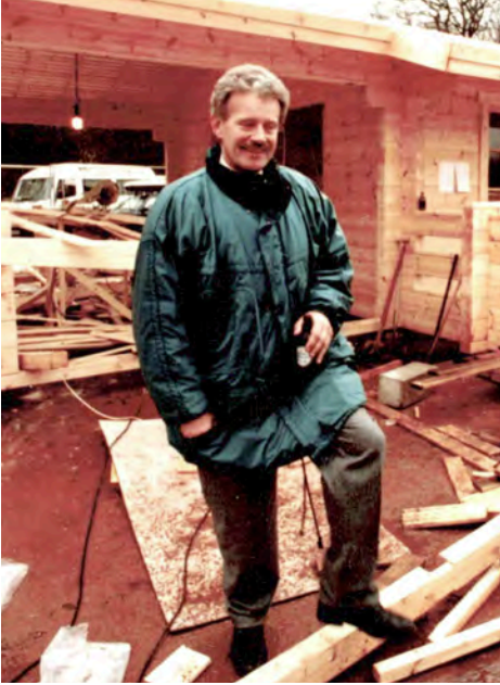
Uwe Rehbein bei den Bauarbeiten, dem das Clubhaus bei der Einweihung gewidmet wurde
